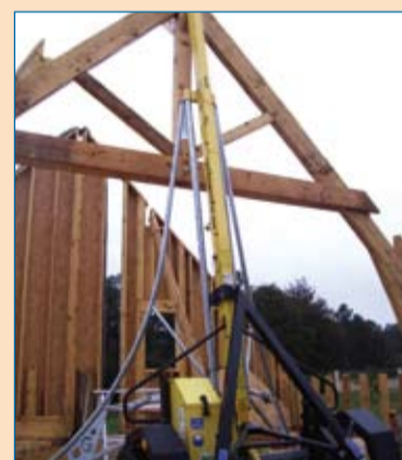
Le Lev'Charpente à l'ouvrage
